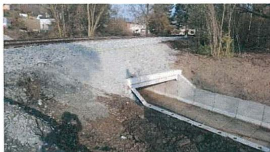
V roce 2021 také započaly přípravy a realizace překrytí částí otevřeného náhonu a tím vytvoření mostků pro bezpečný přechod zvěře.
